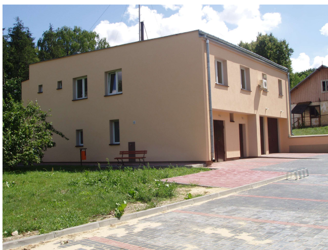
Budynek OPS w Nowodworze.
