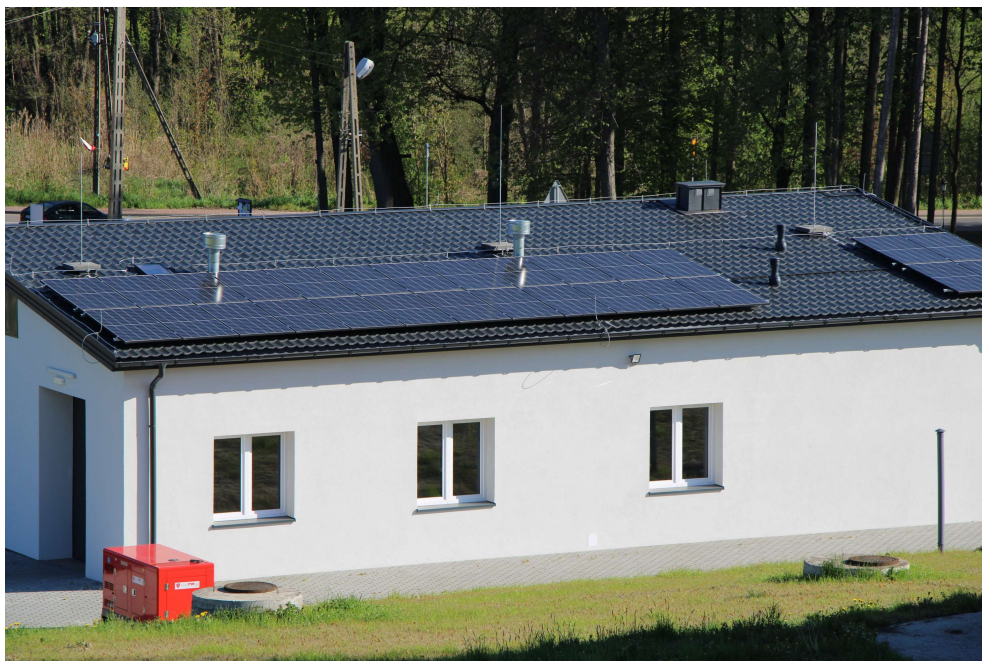
Instalacja OZE na budynku Stacji Uzdatniania Wody w Nowodworze.
